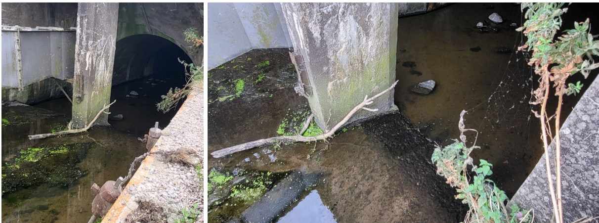
Figur 49. En klack (med en fallhöjd på ca 20 cm) vid ett brofäste vid Jordberga sockerbruk. Vandringshindret är definitivt för mört och möjligen partiellt för öring vid lågflöde.
