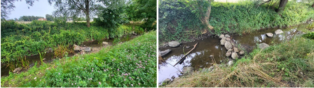
Figur 47. Två mindre dämmen av stenar tvärs över ån på sträcka 11 vid Annexdal. Vandringshindren är partiella vid lågflöde.
