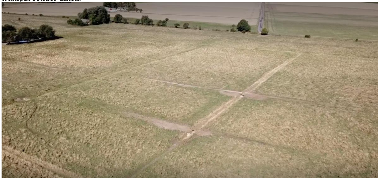
Två av de justerade fördelningsdikena på norra sidan, fördelningsdämmena höjda och förstärkta med sten
